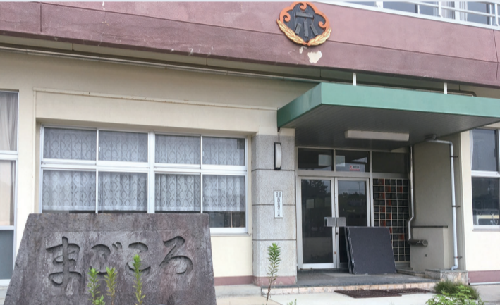
第一小学校正面玄関前 [2017年]
