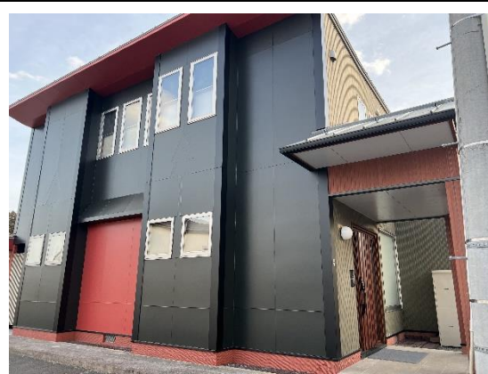
お試し住宅 外観
